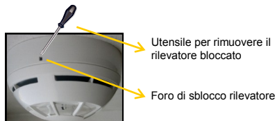
Figura 7 - Rimozione blocco rilevatore
